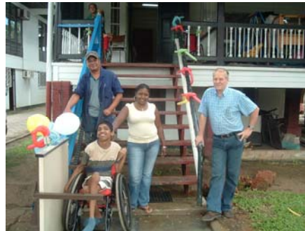
Verzorgsters Ranu met liftinstallateur, de heer van Ommen en diens monteur. Op het liftplateau dagopvangbezoeker Andy,
